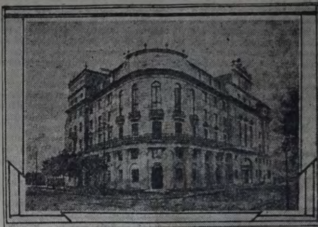
EL EDIFICIO INAUGURADO
